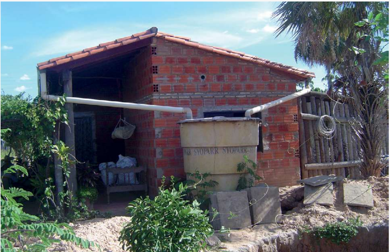
Figura: Techo con sistema de recolección y almacenamiento de agua de lluvia en aljibes Fuente: Karen Stanley
