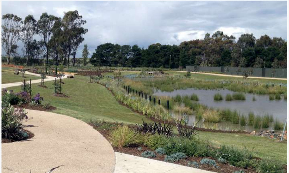
Fig 1: Arriba: Humedal artificial compacto ubicado en el entorno urbano Fuente: https://blogs.nottingham.ac.uk/blue-greencities/files/2017/09/Malmo9.jpg
