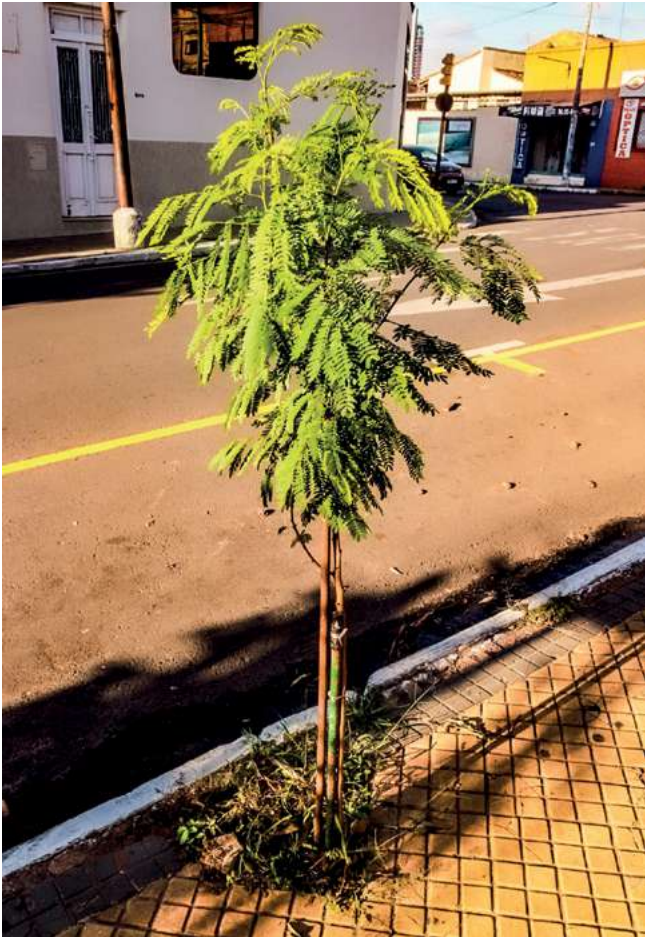
FIGURA 24: Dimensiones insuficientes del cantero en relación con la especie arbórea plantada
