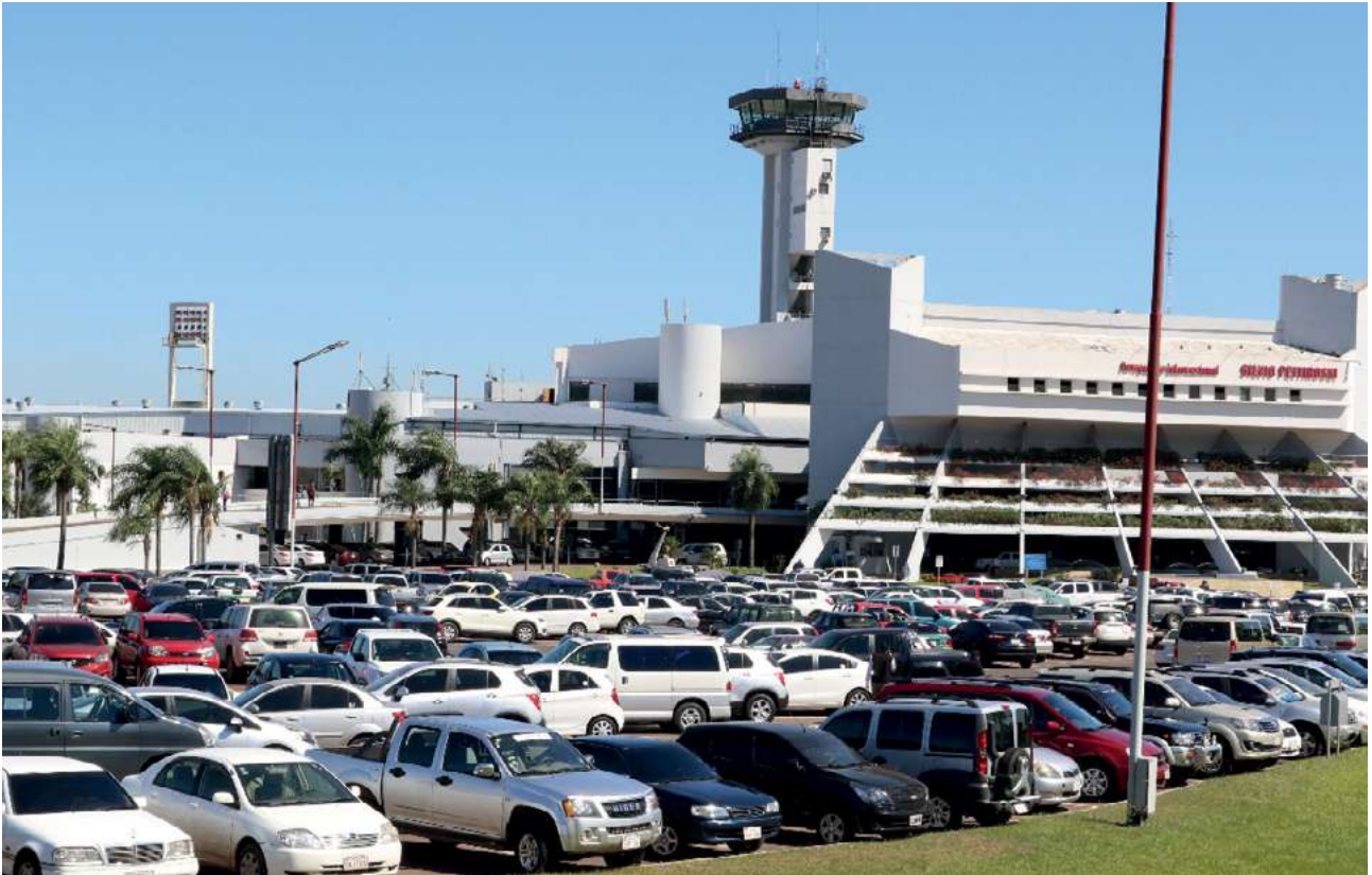
FIGURA 45: Estacionamiento con superficie impermeable y sin vegetación
